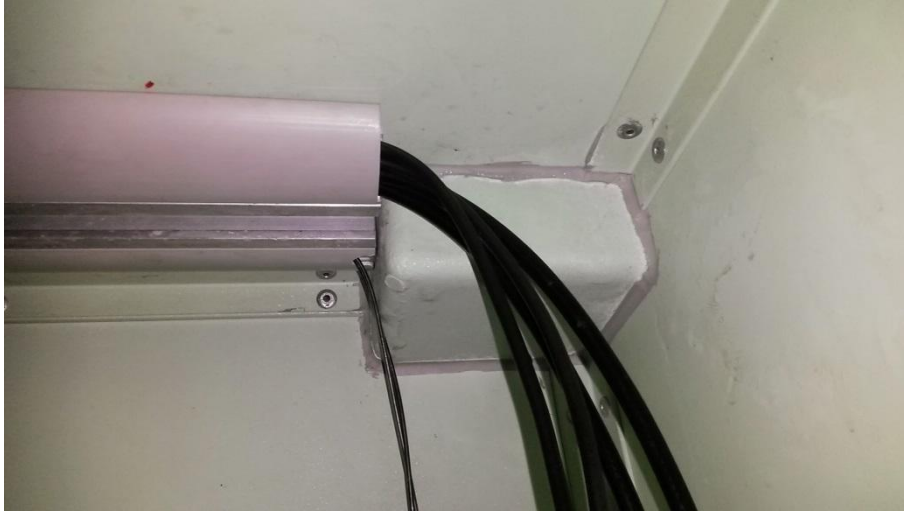
Kabelführung Kabinendecke - Ausgang Eingangsseite, rechts
