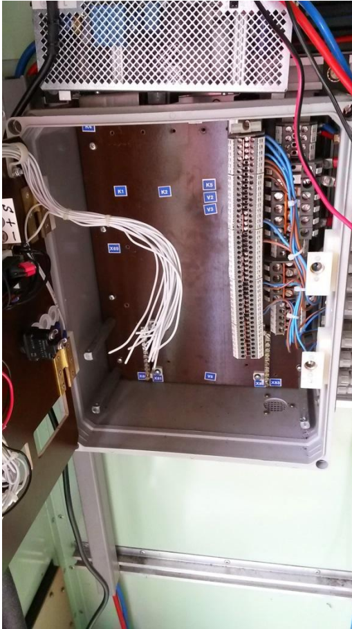
Neuverkabelung - Kabelbaum gekappt
