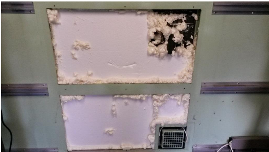
Nahaufnahme - ausgeschäumt wurde auch die Abgasführung der Standheizung
