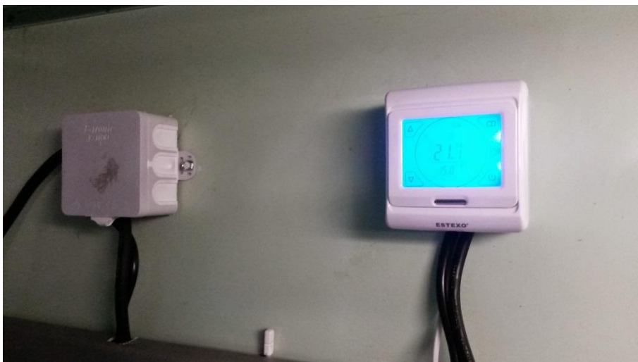
Programmierbarer Thermostat, beleuchtet mit Touchscreen
