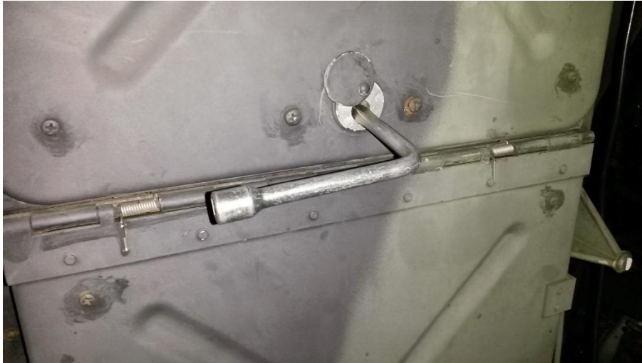
Schlüssel am Anschaltkasten angesetzt
