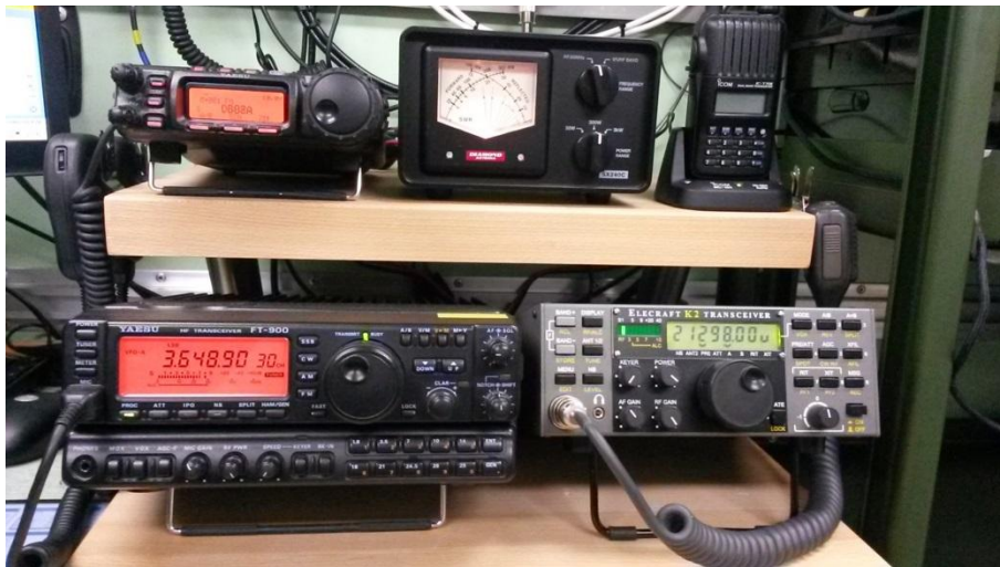
Die Funkgeräte befinden sich in optimaler Arbeits-/ Bedienhöhe
