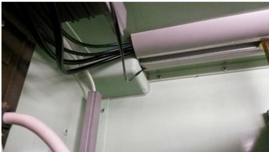
Kabelführung Kabinendecke - Ausgang Stirnseite, rechts
