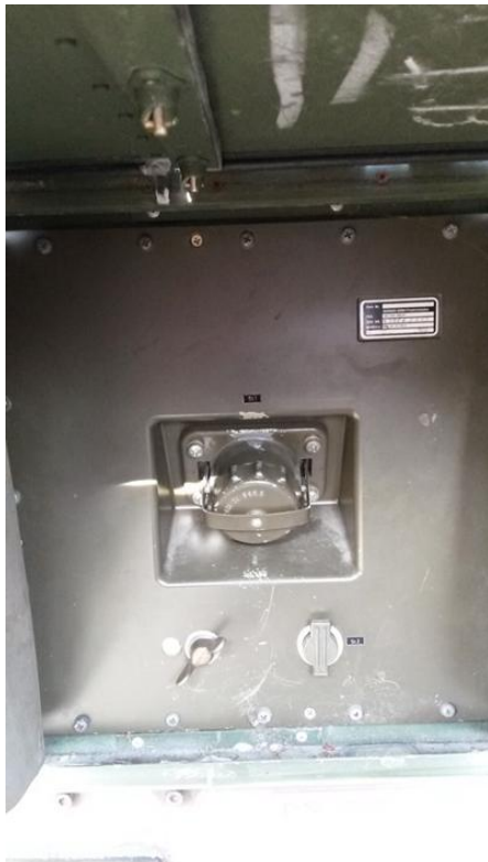
Netzanschaltkasten, links
