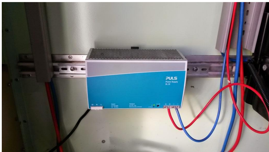
Puls Netzteil 24 Volt 20 Ah montiert auf Hut-Schiene
