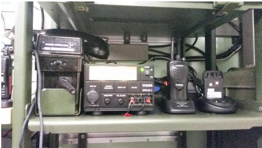
Regal rechts neben dem Operatorplatz (Mittelfach): Feldfernsprecher / 50 Ah-Netzgerät / Ladestationen
