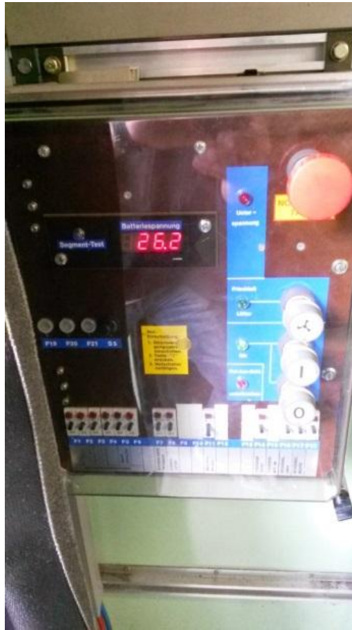
Verteilerkasten mit der ersten Anzeige
