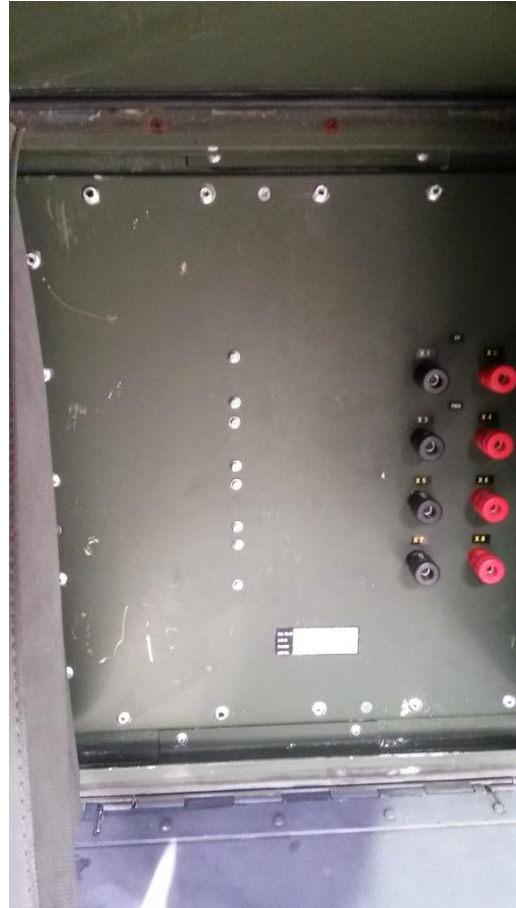
Anschaltkasten, rechts-oben Anschluss Feldfernsprecher
