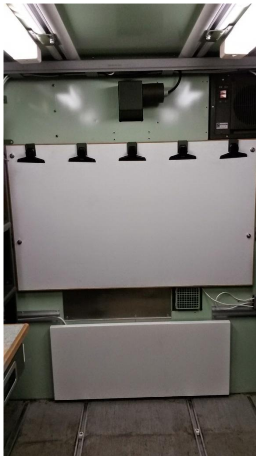
Wandtafel und Infrarotheizung an der Stirnseite
