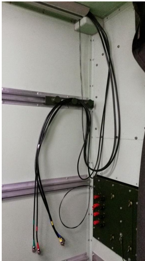
Kabel - noch nicht angeschlossen
