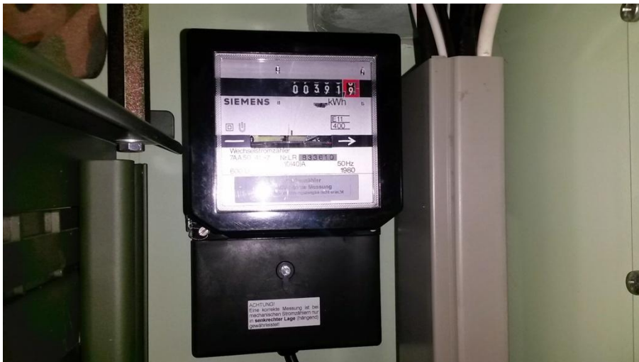
Einfacher (regenerierter) Zwischenzähler
