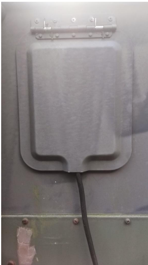
230 Volt Außenanschluss an der Stirnseite, außen - regengeschützt durch Klappe
