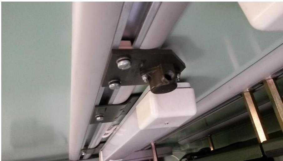
Ursprünglicher Montageort der 24 Volt Steckdose - C-Schiene Kabinendecke, rechts
