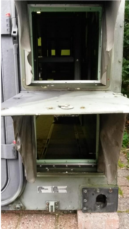
Anschaltkästen, rechts - ausgeschlachtet
