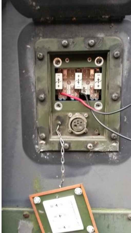
Ladeanschaltkasten - 24 Volt Anschluss mit provisorisch angeschlossenem Netzgerät
