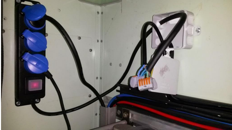
230 Volt Hauptschalter (links) über schaltbare 3er Steckdosenleiste
