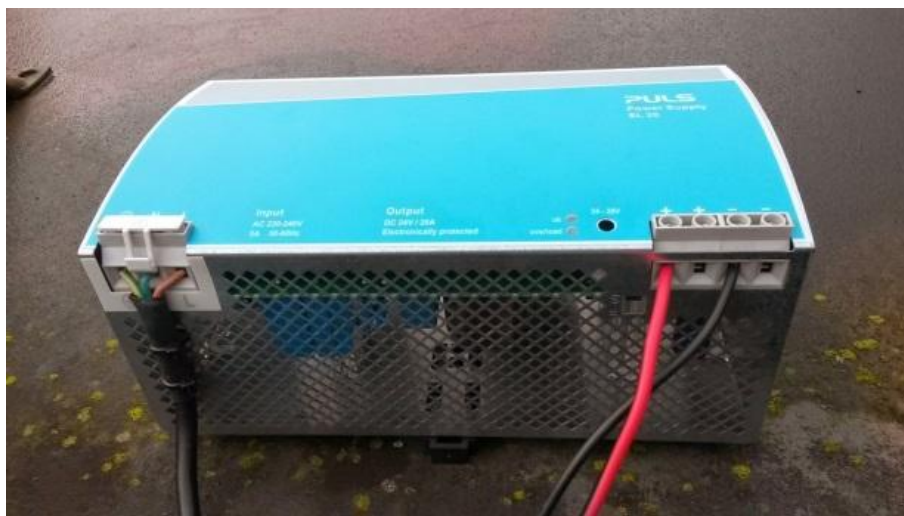
Puls Netzgerät übergangsweise auf dem Kabinendach
