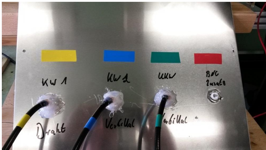
Antennenanschlüsse für den Anschlagkasten, rechts-unten (Innenansicht)
