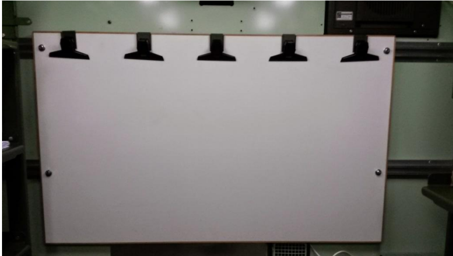
Wandtafel - erkennbar die 4 Befestigungsschrauben auf Höhe der C-Schienen
