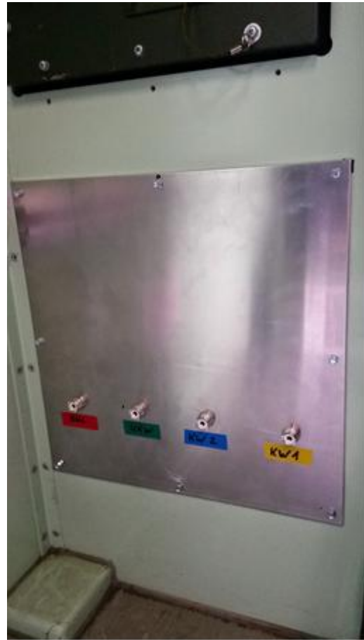
Anschaltkasten, rechts-unten Innenansicht
