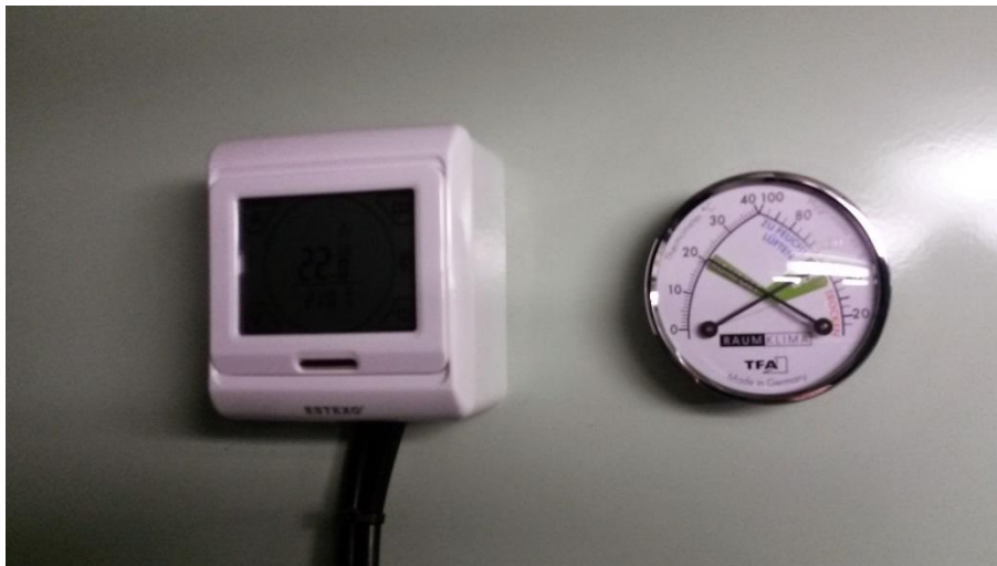
Hygrometer zur Überwachung des Raumklimas (rechts neben dem Thermostat der elektrischen Heizung)
