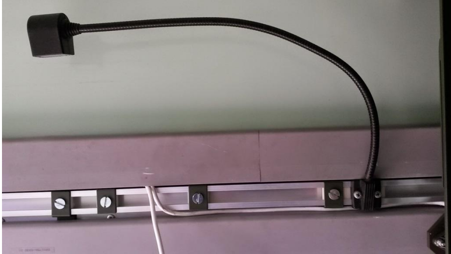
24 Volt Hella Leselampe an C-Schiene montiert (Probemontage noch ohne Kabel)
