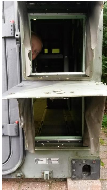
Anschaltkästen, rechts-unten und rechts-oben
