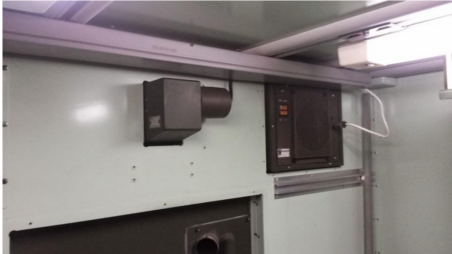
230 Volt Durchführung in die Kabine - rechts daneben 24 Volt Zusatzlüfter
