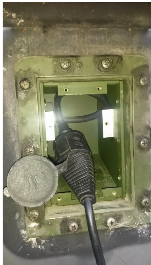
230 Volt Außenanschluss an der Stirnseite, außen - regengeschützt durch Klappe
