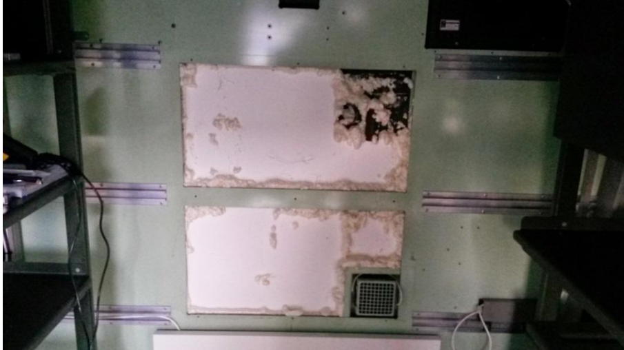
Gitteröffnungen der ehemaligen Standheizung - ausgeschäumt und mit Styropor isoliert
