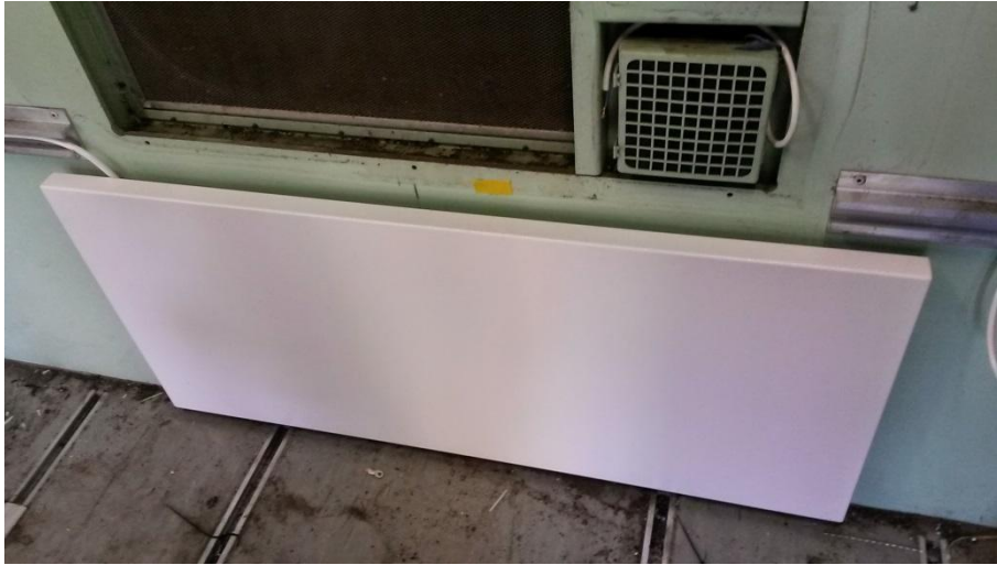
230 Volt / 450 Watt Infrarot-Heizpanel - rechts darüber 24 Volt Frischluftlüfter
