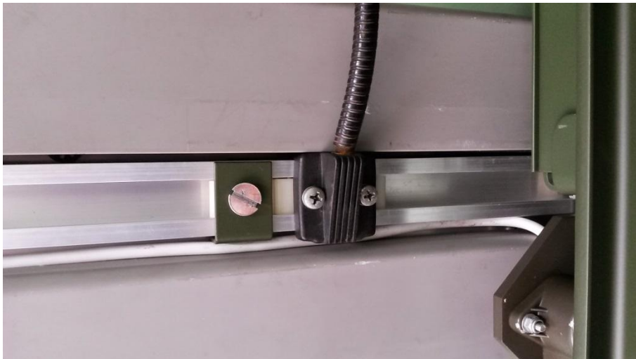
Verwendet wurden zwei C-Riegel mit kleinem Gewinde (Probemontage)
